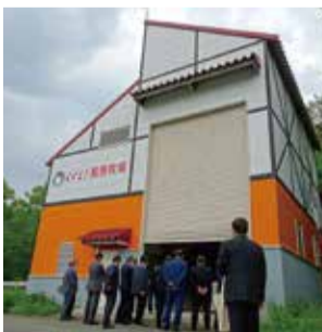
木質バイオマスガス化発電設備 (くずまき高原牧場)
